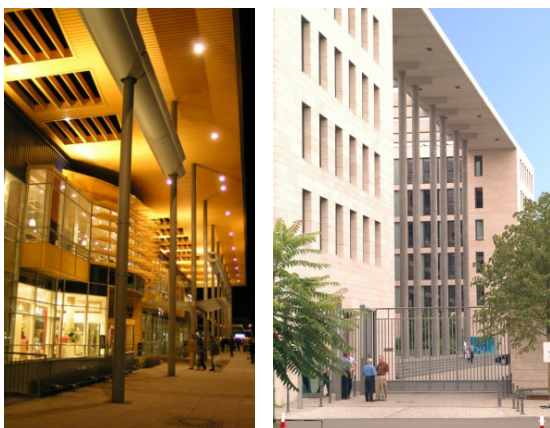
BILD 1 Beispiele für schlanke Schleuderbetonstützen Eurocoles GmbH & Co. KG (links: IKEA, Dresden; rechts: Auswärtiges Amt, Berlin) /1/
