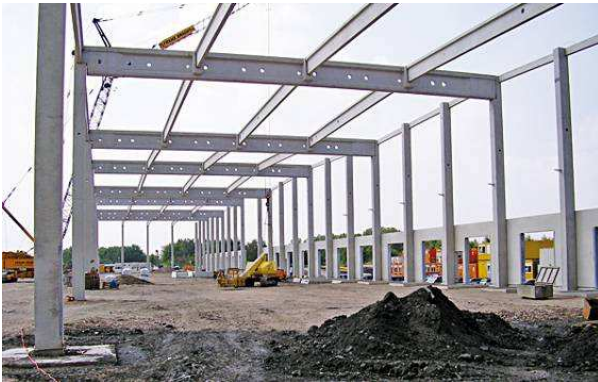
BILD 1 Logistikzentrum in Betonfertigteilmbauweise
