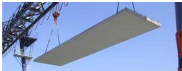
BILD 2 Spannelementdecke
