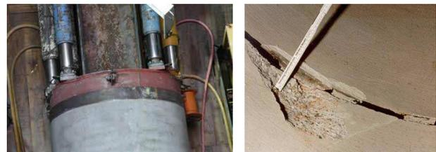
BILD 2 Rohrvortrieb (links), Kantenabplatzung (rechts)
