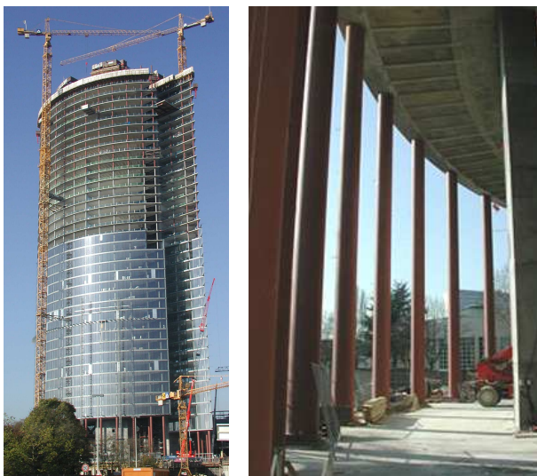
BILD 1 Post-Tower in Bonn als Beispiel für derzeitige Hochhauslösungen und Stützenausbildungen
