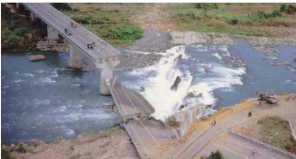
BILD 5 Brückeneinsturz an geologischer Verwerfung
