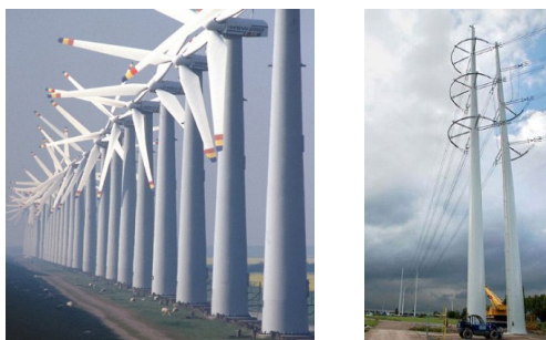
BILD 1 Mögliche Anwendungsbereiche der dünnwandigen Rohrprofile aus UHFB
