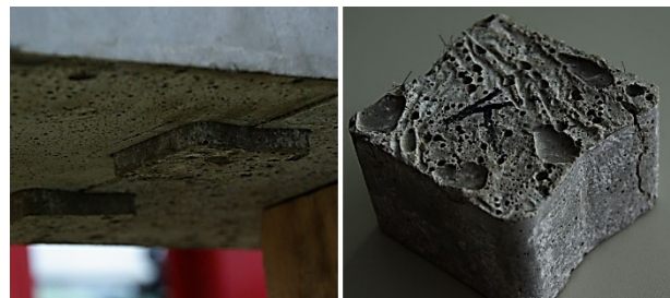
Bild 7: UHPFRC Inlays vor dem Einschlagen in der Mitte der Zugzone unterhalb des Balkenstoßes (links) und geschädigter UHPFRC-Inlay nach dem Versuch (rechts)
