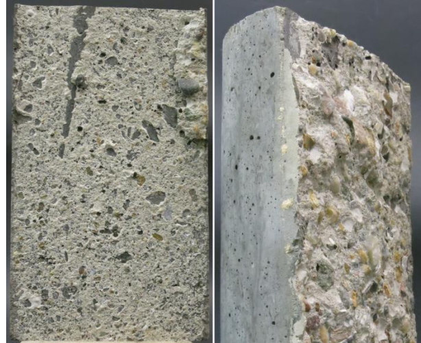
Bild 5: Spaltzugversagen an Zylindern mit Oberflächenvorbereitung mittels Fräsen mit oberflächlichem Kohäsionsbruch (links) und HstDW Oberfläche mit reinem Kohäsionsbruch (rechts)
